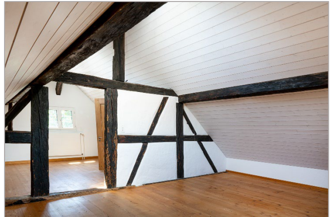
Dachausbau Haus Süd
