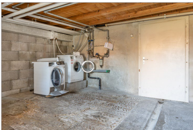
Waschküche zu Hausteil Süd (unter Haus Nord)
